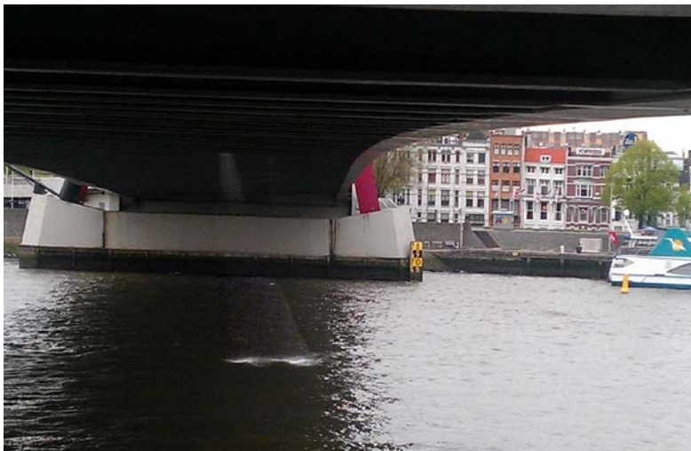
Figuur 5.3 Voorbeelden lekkage bij twee incidenten in Rotterdam. Op de bovenste twee foto's ziet u de gevolgen van gronduitspoeling door lekkage van een leiding van 1600 mm. Op de onderste twee foto's ziet u een lek door corrosie in een leiding onder een brug. Tracé regelmatig langslopen heeft zin en voorkomt mogelijk erger.
