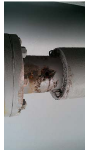
Figuur 5.3 Voorbeelden lekkage bij twee incidenten in Rotterdam. Op de bovenste twee foto's ziet u de gevolgen van gronduitspoeling door lekkage van een leiding van 1600 mm. Op de onderste twee foto's ziet u een lek door corrosie in een leiding onder een brug. Tracé regelmatig langslopen heeft zin en voorkomt mogelijk erger.
